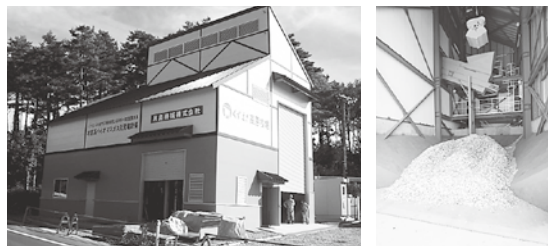
図表1 木質バイオマス発電設備
