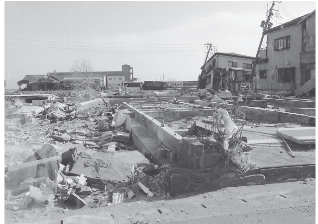
写真1：A小学校 校区内の被災状況
