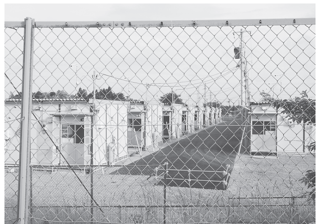
写真2：B中学校の傍に建築中の仮設住宅
