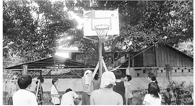
写真1 バスケットゴールポストの修繕
