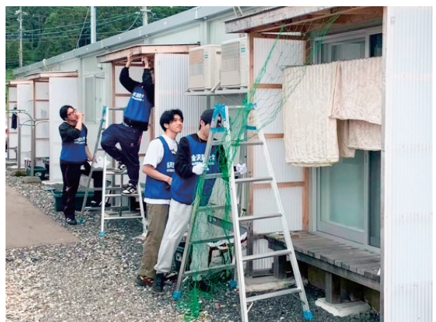
写真1 脚立を使用してネットを設置
